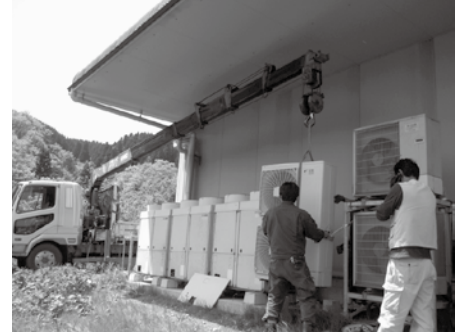
空調機を入れ替えているところ。
