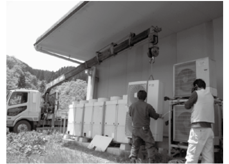
空調機を入れ替えているところ。
